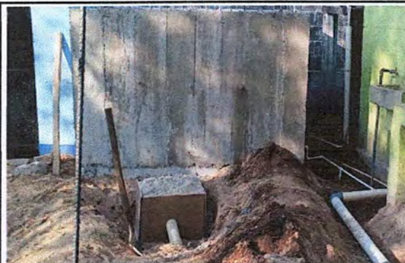
Foto 2: Reparacion e Instalacion de tuberia.
