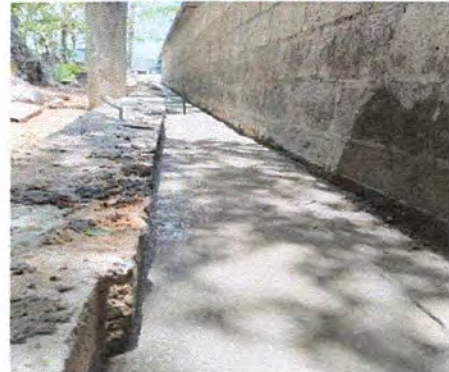
Foto 4: Fundición de la cuneta de concreto.
