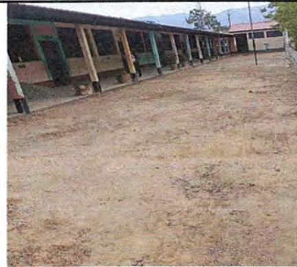
Foto 2: Nivelación del patio a fundir.
