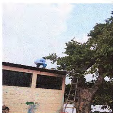
Foto 1: Cambio de la lamina dañada.
