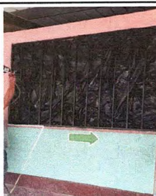
Foto 2: Utilización de pintura anticorrosiva.
