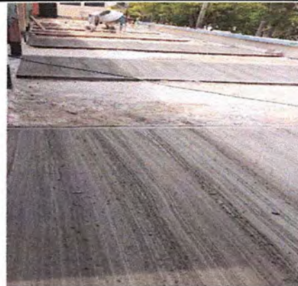
Foto 4: Fundición de losa por cuadros.
