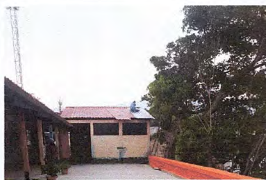
Foto 2: Instalación de la lámina nueva.
