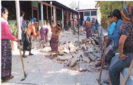
Foto 1: Demolición de la losa de patio.
