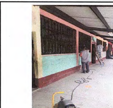
Foto 1: Mantenimiento de balcones.
