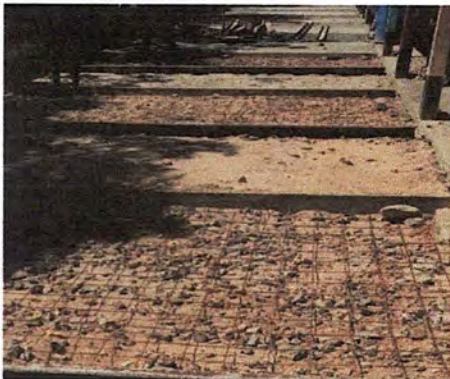
Foto 3: Colocación de la electromalla previo a la fundición.
