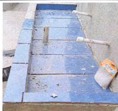
Foto 4: Lavamanos de concreto.
