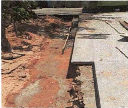
Foto 1: Lugar donde inicia la cuneta de concreto.
