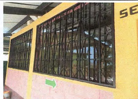
Foto 3: Balcones ya instalados
