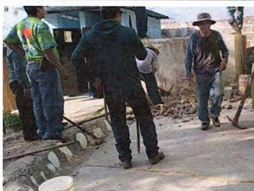
Foto 1: Inicio del mejoramiento.
