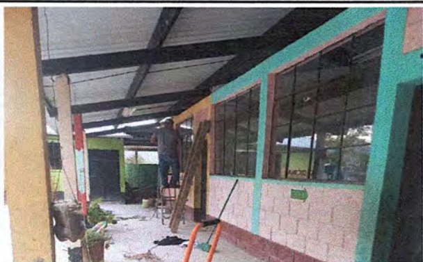
Foto 1: Inicio de la instalacion de balcones.
