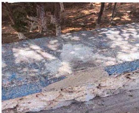
Foto 1: Reparacion en partes dañadas.
