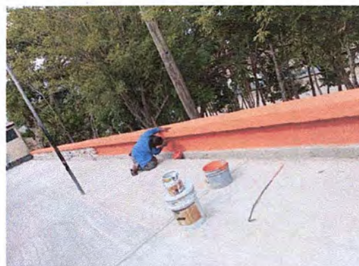
Foto 4: Pintado del muro medianero.
